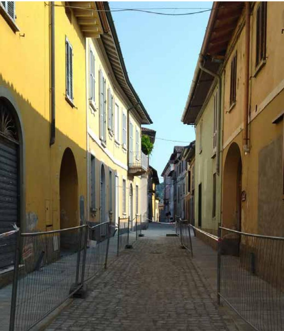
**A**l lavoro per il rifacimento stradale di Via Manzoni. Il cantiere per la sostituzione dell'asfalto con una nuova pavimentazione con pietre di Luserna, partito a maggio, è in fase avanzata e si concluderà, salvo imprevisti, entro luglio. Tempi rispettati, malgrado le frequenti - ma attese e necessarie - piogge che si sono presentate in contemporanea con i lavori. Già si nota il cambio di aspetto della parte rinnovata, con la via principale del
