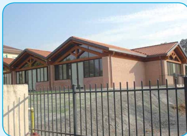
L'ampliamento delle scuole elementari è terminato. Inaugurazione il 20 dicembre
