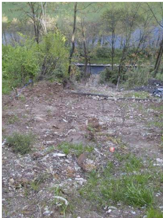
Figura 1 Smottamento presso il ristorante "Toscano"
