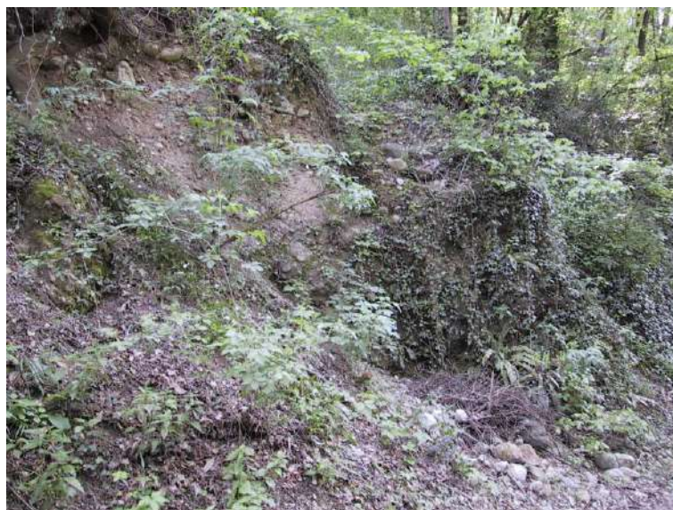
Figura 2 Smottamento lungo la scarpata del fiume Adda
