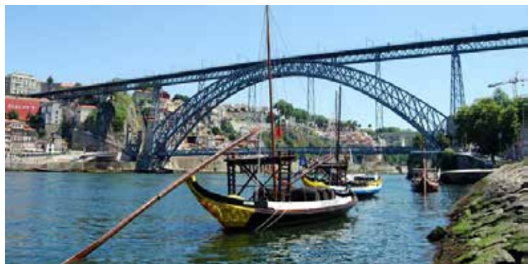
Ponte Dom Luis I° sul Douro a Oporto Vila Nova de Gaia - Portogallo (1886)
